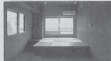
モルタルの土間に小上がりを設置＝リズム提供
